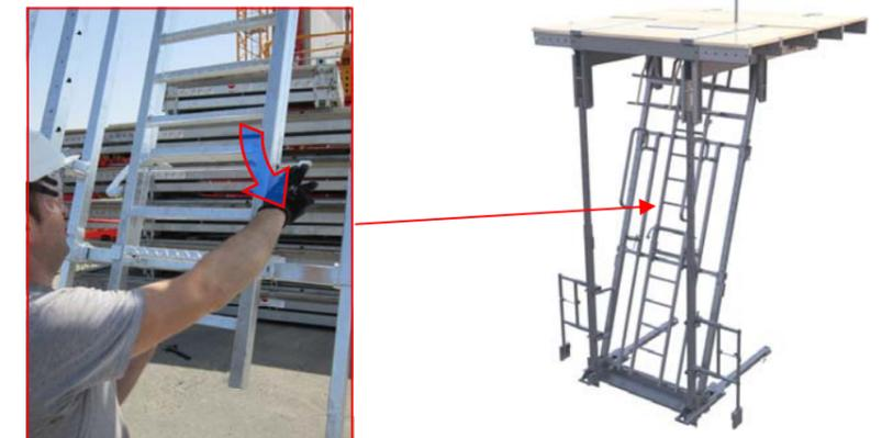
Le PCA est prêt à être installé dans la cage. Pour cela, lever manuellement le balancier pour l'engager lors de la 1ère mise en place.
